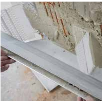
Einstellen der Auftragsdicke
